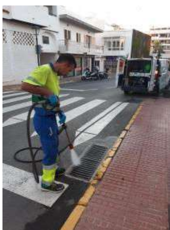
Un operario limpiando las alcantarillas de una calle de Santa Eulària | Foto: Ayuntamiento de Santa Eulària
