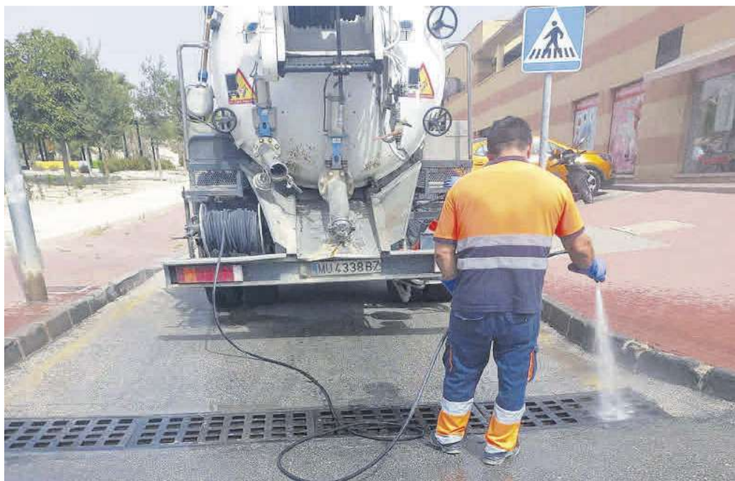
Un efectivo municipal limpiando imbornales en Molina de Segura.
