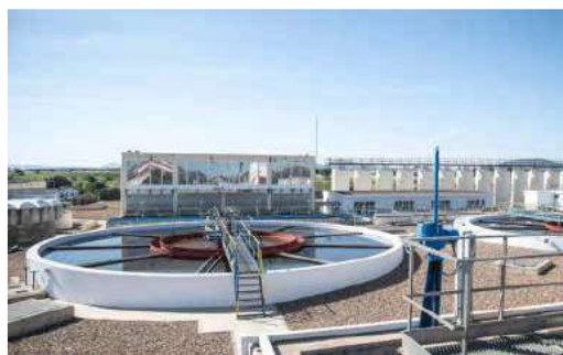
Planta potabilizadora de Mérida.
