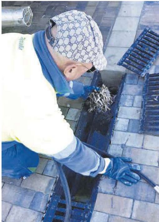
Un operario retira vegetación de una alcantarilla.
